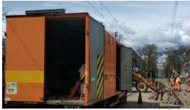
Szczecin: torowisko do remontu
